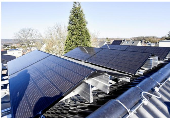
**Eine spezielle Alukonstruktion sorgt dafür, dass das Dach mehr Fläche für die Solarzellen bietet.**
